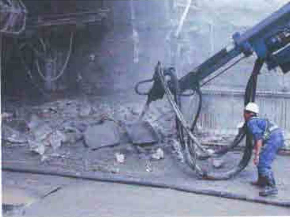
Máy phun vữa khí thi công Hầm Hải Vân
