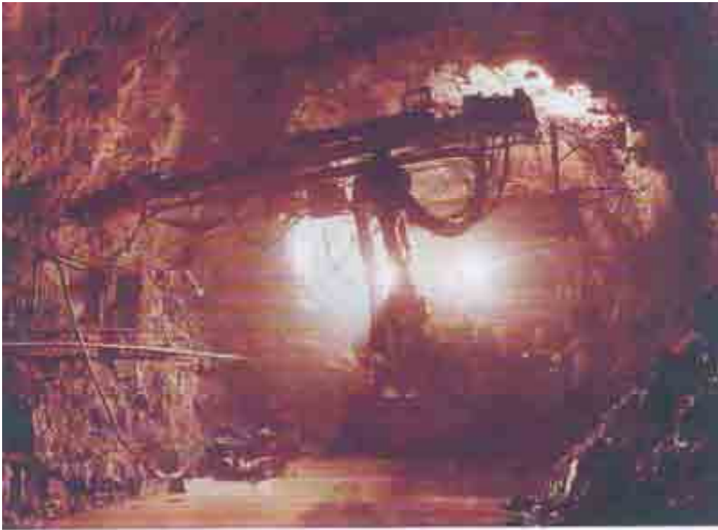
Khoan lỗ lắp đặt neo trong thi công hầm Hải Vân
