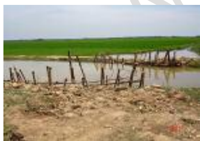
Kênh chính của hệ thống Kê gỗ
