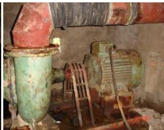
Máy bơm của HTDN Cẩm Lộc hỏng không có tiền để sửa chữa (1)
