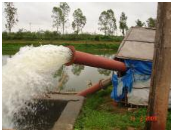
Nông dân cần nâng cấp các trạm bơm mà họ đã bỏ vốn đầu tư XD ( Quảng Bình )
