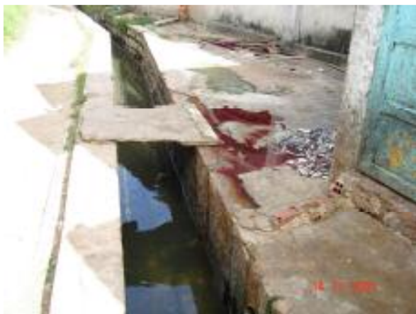
Hình 6: Kênh thoát nước thải
