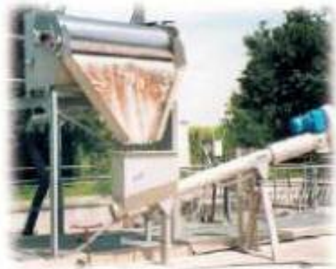
Hình 9: Thiết bị ép chất rắn sau sàng lọc HUBER Ro7
