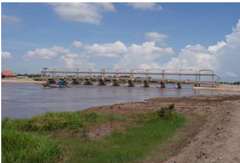
Hình 6: Cống Láng thê, Trà vinh (tổng khẩu diện 100m) có nhiệm vụ ngăn mặn, lấy ngọt và tiêu úng, trong tương lai nước biển dâng sẽ làm mất khả năng lấy ngọt cho dự án NMT
