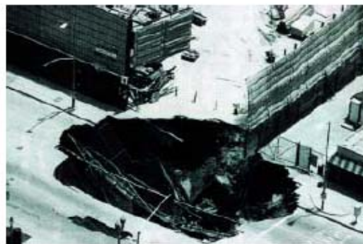
Hình 4. Sụp lở phát triển tới bề mặt a. Trong khu vực ngoại thành b. Trong khu vực đô thị
