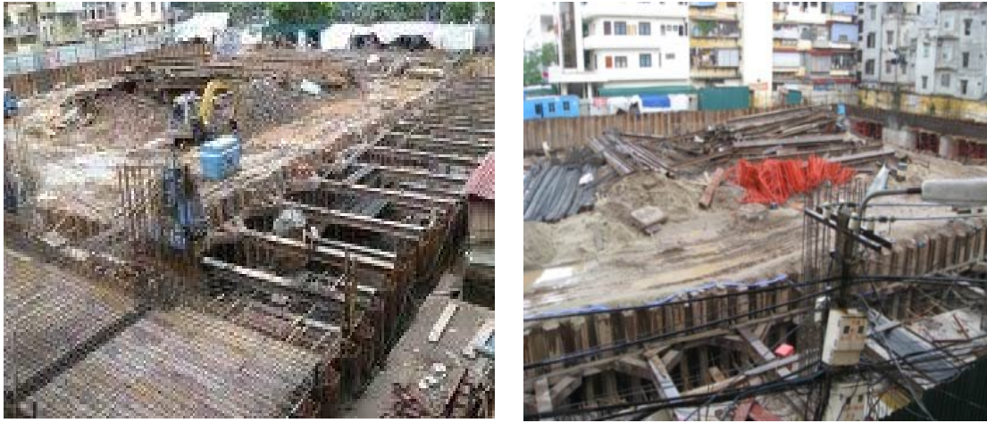
Hình 11. Hiện trạng thi công nhà 34 tầng và 2 tầng hầm
