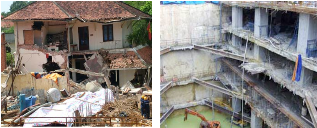
Hình 10. Hồ móng 5 tầng hầm của công trình Pacific
