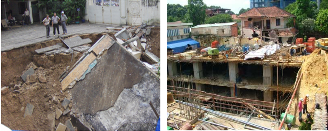
Hình 9. Nhà Viện KHXH sập nằm dưới hầm công trình của cao ốc Pacific
