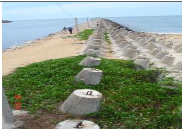
Hình 2. Đê chắn sóng khu neo đậu TTB
