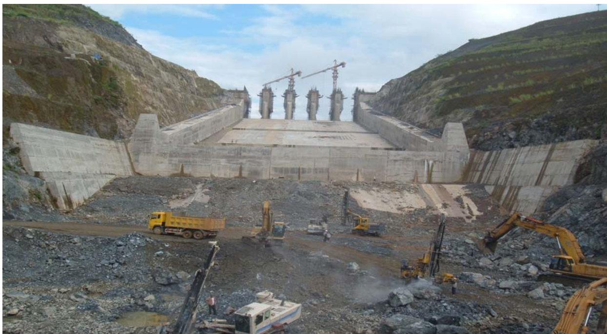
Thi công tràn xả lũ trên công trường đập Cửa Đạt
