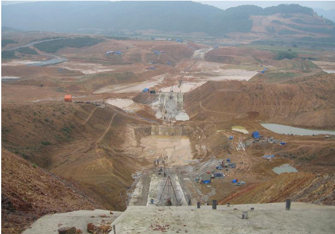
Khoan phụ gia cố nền tuyến tim đập chính phía bờ phải
