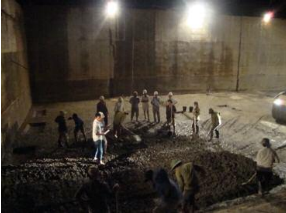
Đổ bê tông
