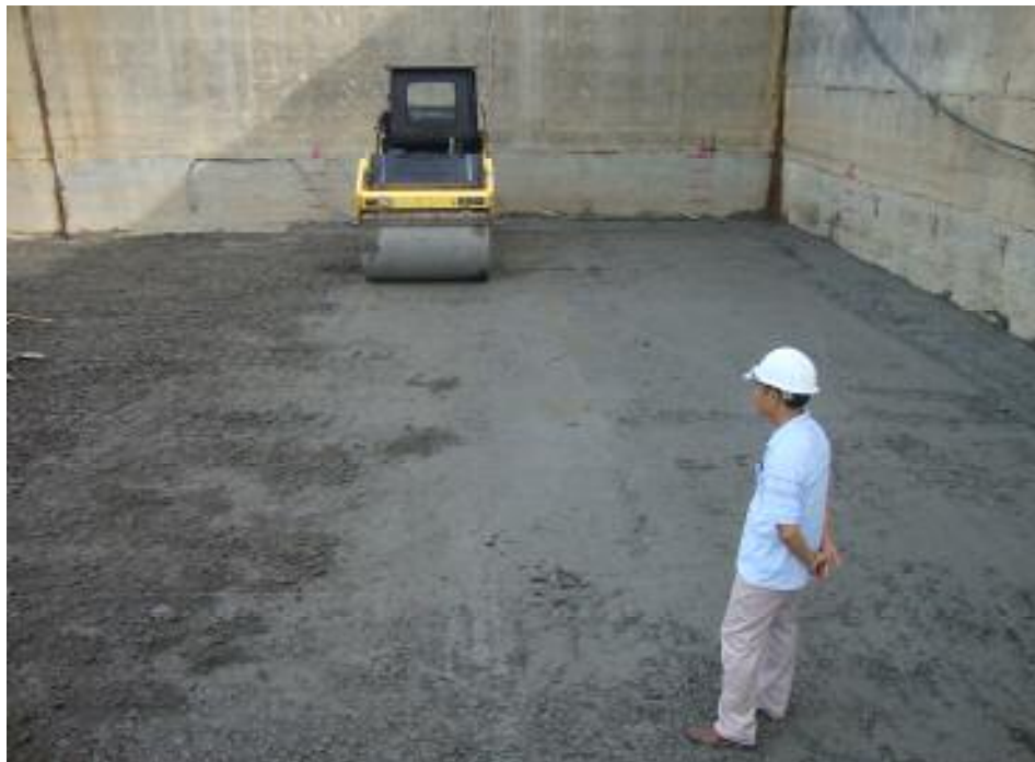
Đầm lăn bê tông
