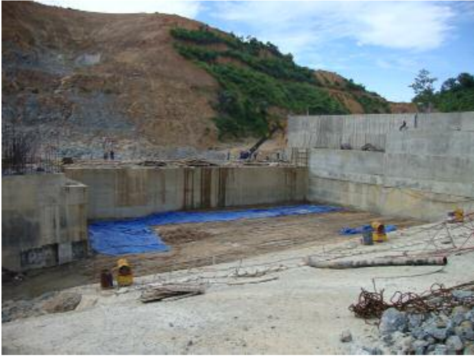
Bảo dưỡng bê tông
