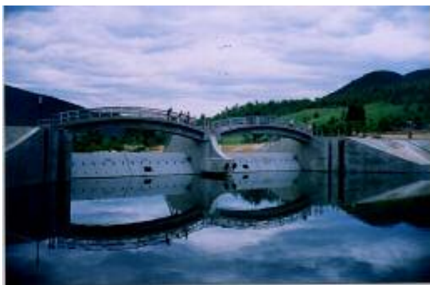
Mức nước chết trong hồ, cửa van đóng do áp lực nước ở thượng lưu. Nhìn từ thượng lưu (trái) và từ hạ lưu (phải).
