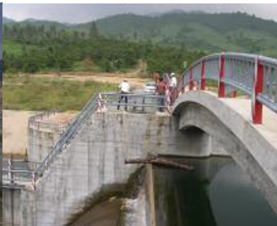
Cửa van mở, tràn xả lũ (trái). Nhiều thiết bị được đặt trong trụ pin (phải)
