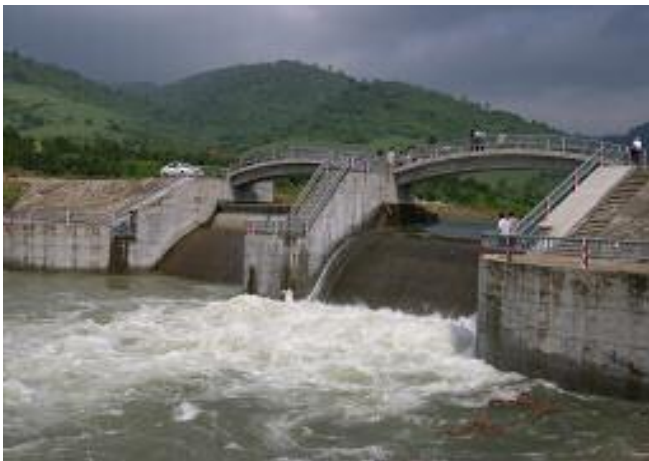
Cửa van mở, tràn xả lũ (trái). Nhiều thiết bị được đặt trong trụ pin (phải)
