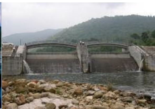
Mức nước chết trong hồ, cửa van đóng do áp lực nước ở thượng lưu. Nhìn từ thượng lưu (trái) và từ hạ lưu (phải).
