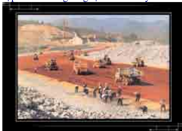
Hình ảnh thi công lõi đập đá đổ
