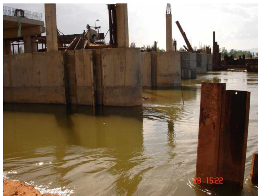
Thi công cống ngăn mặn Đò Điểm trên sông Nghèn (Hà Tĩnh)
