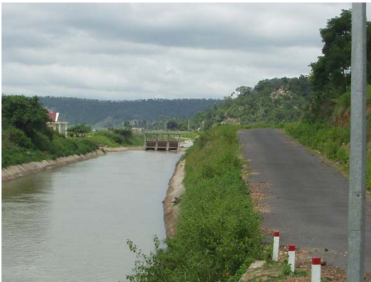
Kênh chính hệ thống thủy lợi Ayun Ha (Gia Lai)
