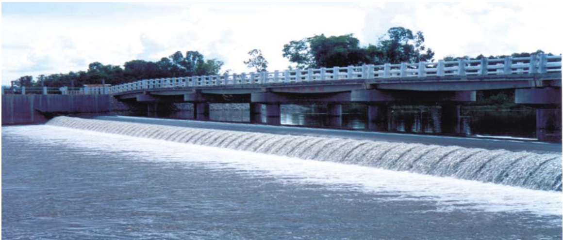
Đập tràn Trà Sư (An Giang) là đập cao su lớn nhất nước ta hiện nay
