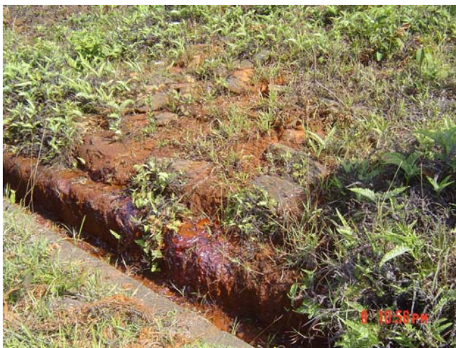
Nước thấm ra máng hạ lưu đập gây mất an toàn tại đập Khe Nậy (Hà Tĩnh)
