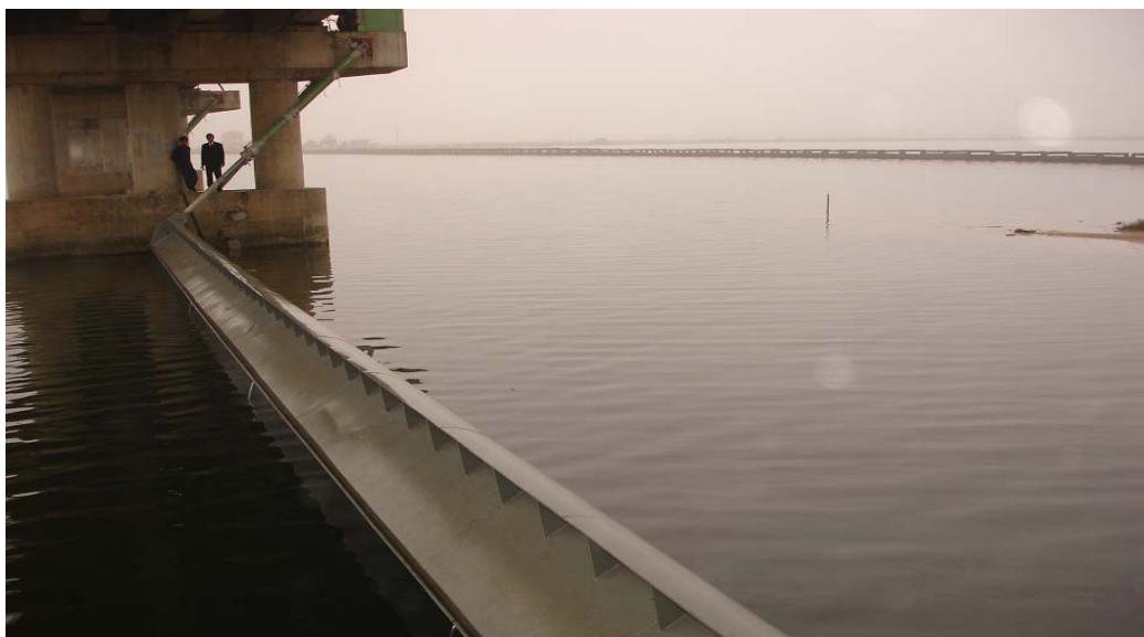
Lắp đặt Cửa van đập Thảo Long (Huế) trong nước, khẩu độ 33m, truyền động piston thủy lực
