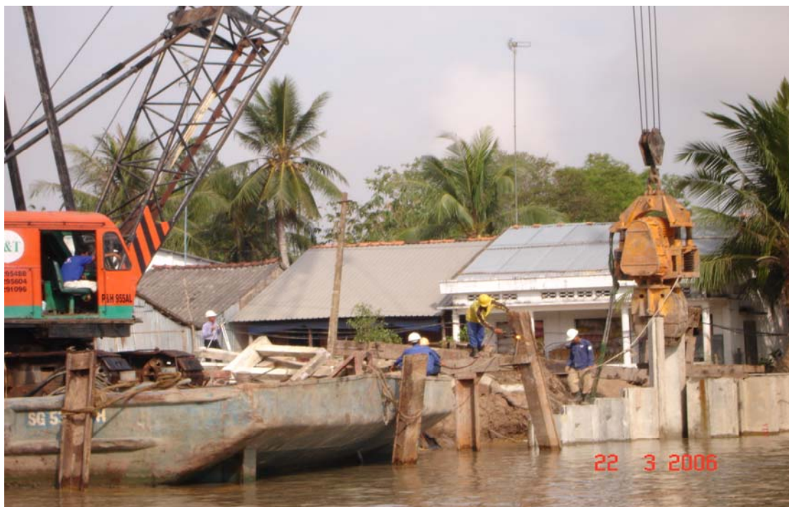
Thi công thủy lợi tại Đồng bằng sông Cửu Long
