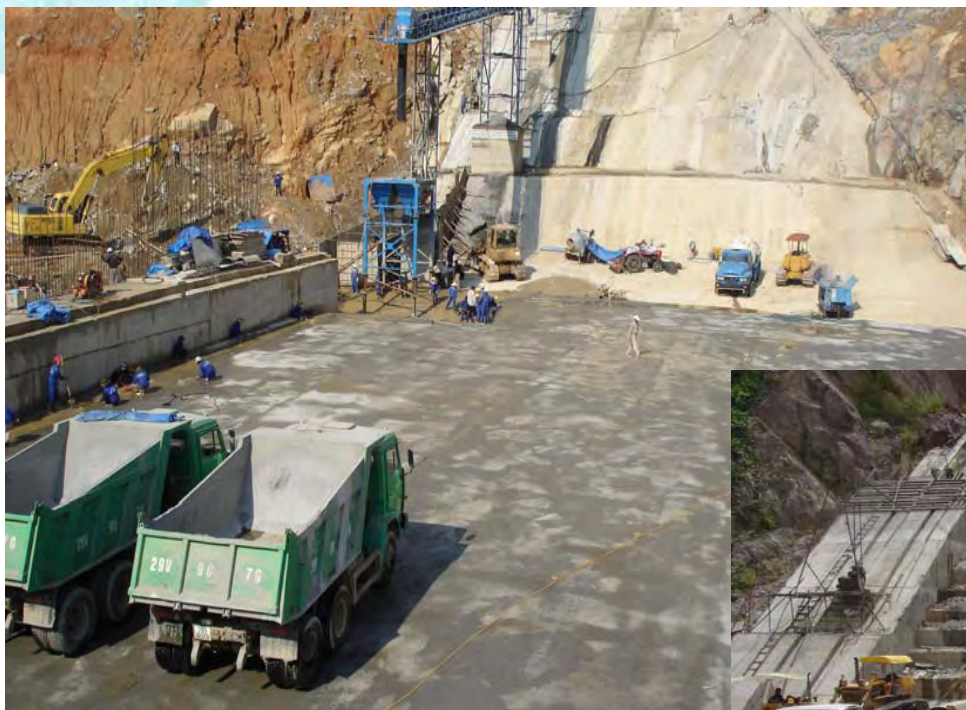
Đập thủy điện Pleikrong đang xây dựng (2003-2007)
