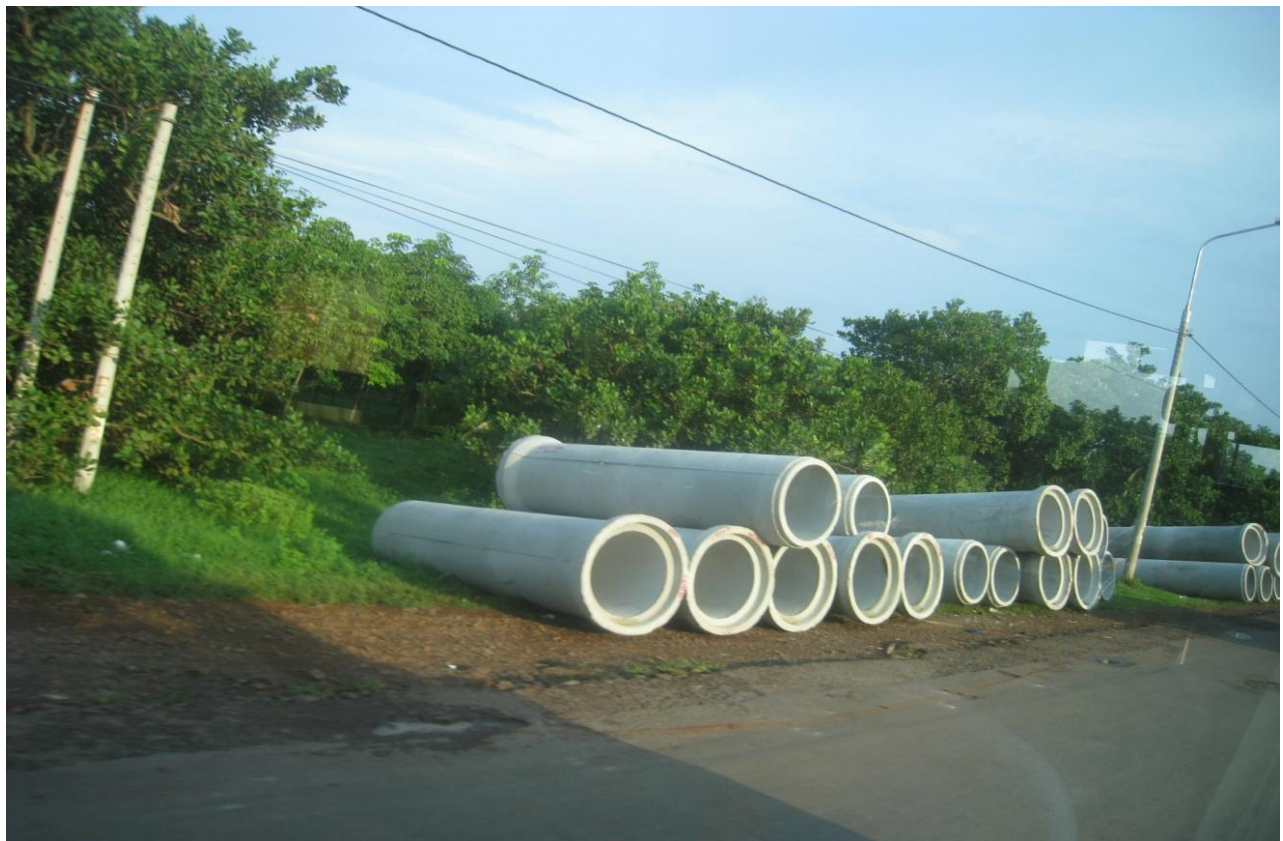
Chuẩn bị đặt cống dọc QL20
