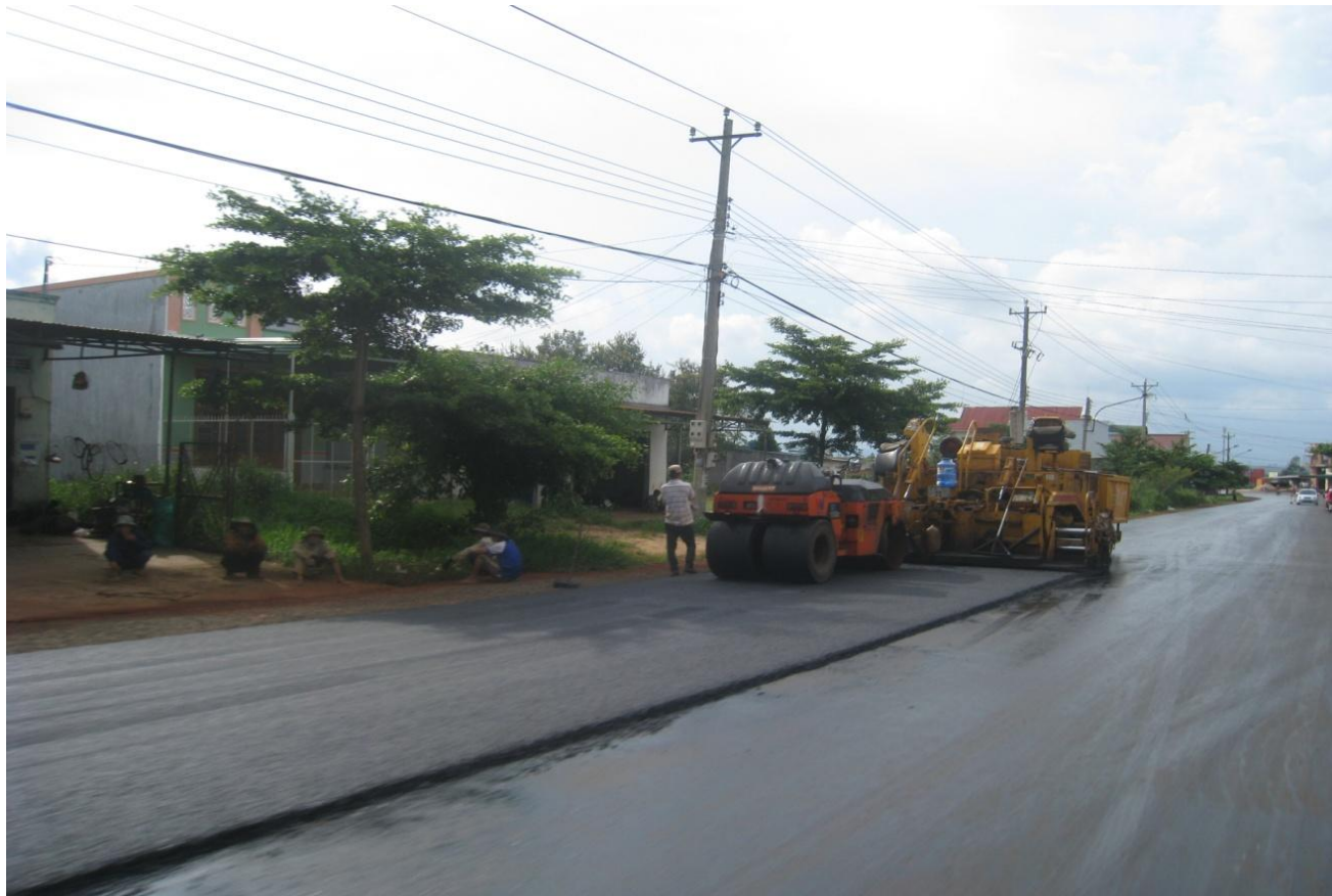
Công ty cổ phần xây lắp Dầu khí 1 đang thảm bê tông nhựa nóng đường 725
