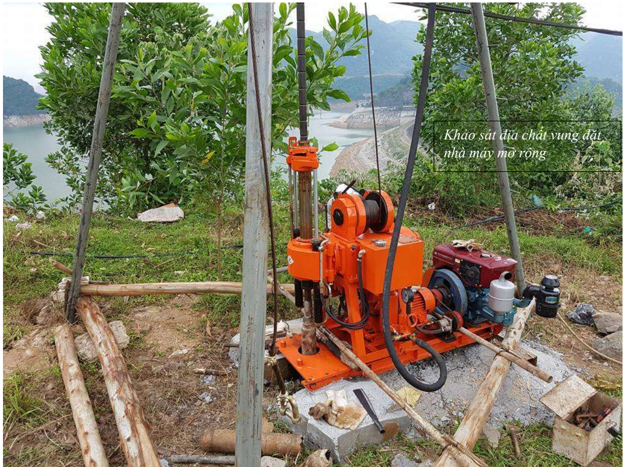
Nơi đặt nhà máy mở rộng Thủy điện Hòa Bình
