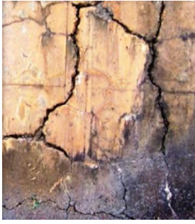
Bê tông bị nứt do các phản ứng kiềm và cốt liệu
