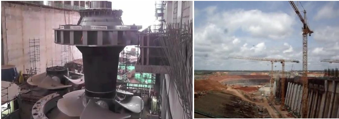
Lắp đặt tuabin (trái) và thi công đập (phải)
