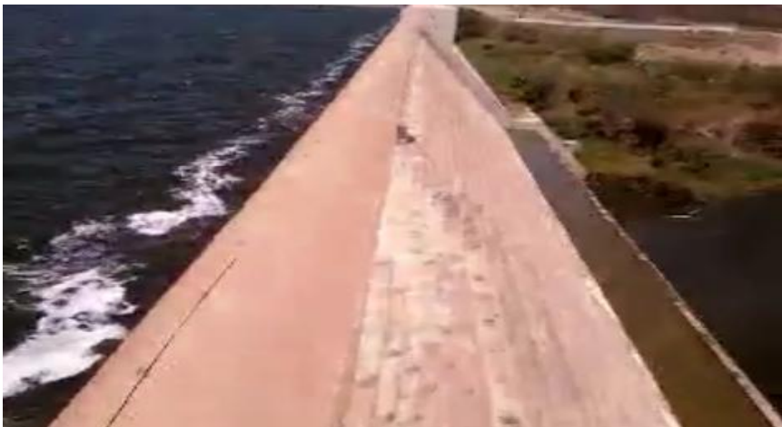
Đập chính bê tông đầm lăn (RCC) (chụp từ trên cao)
