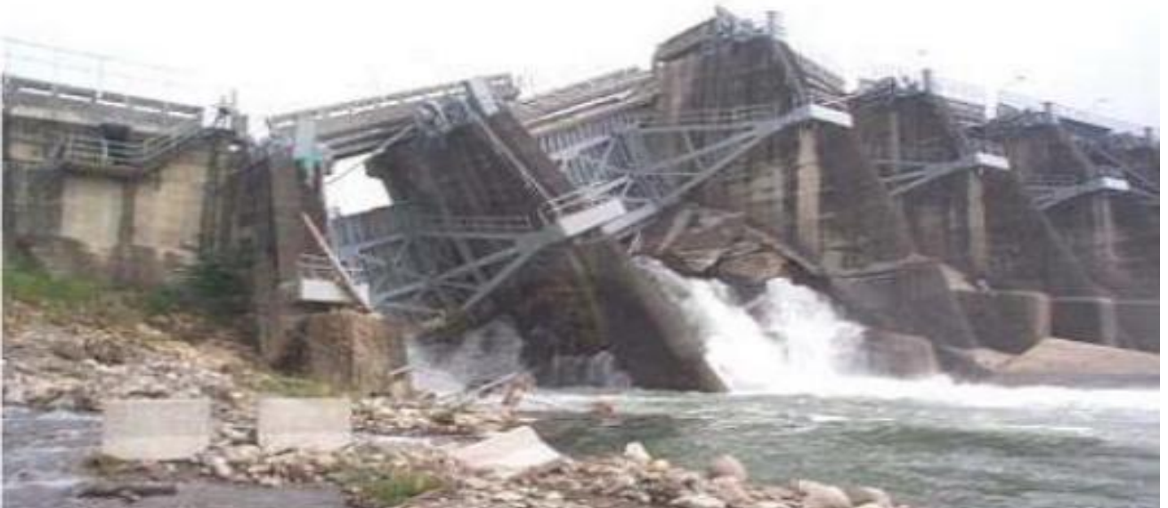
Đập Shi Gang (trên) và cảnh tượng bị hư hại do động đất năm 1999 (dưới)
