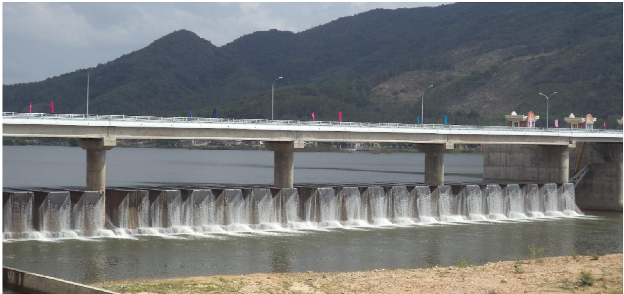
Toàn cảnh đập dâng Văn Phong và ngưỡng tràn kiểu phím đàn (PKW) dài nhất thế giới
