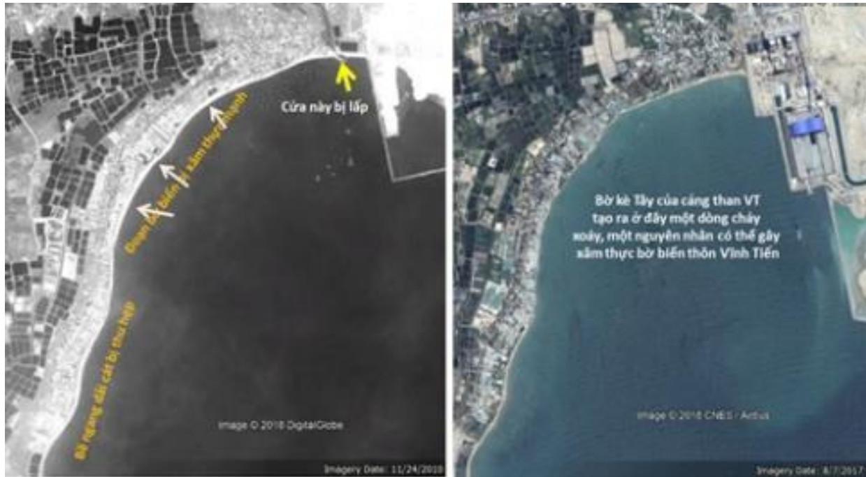
Hình 4a. Bờ biển thôn Vĩnh Tiến bị xâm thực. Ảnh vệ tinh 24.11.2010 và 07.08.2017
