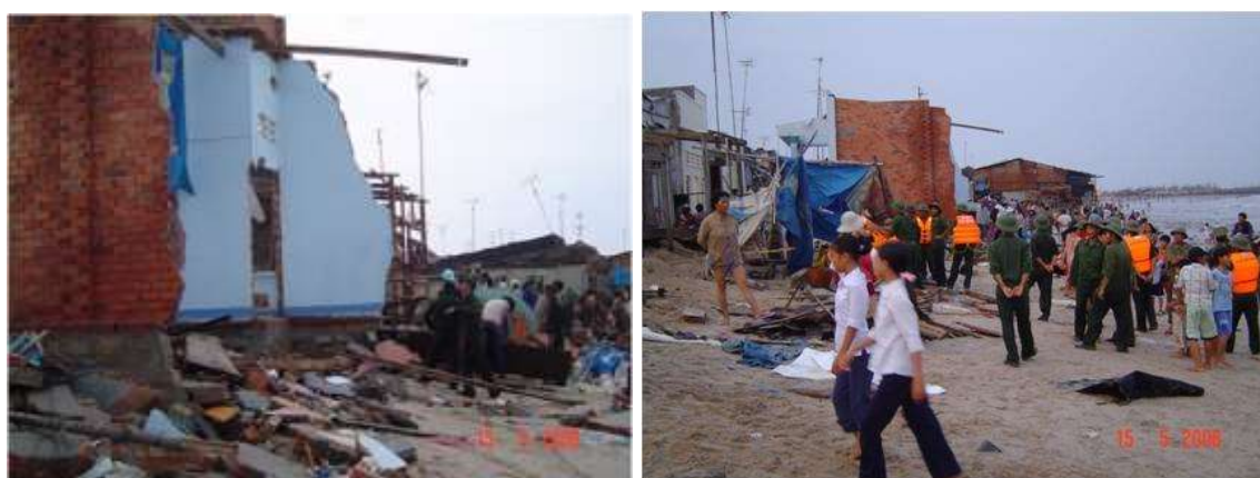
Hình 5: Xói lở bờ biển tại Đức long, thị xã Phan thiết, Bình thuận
