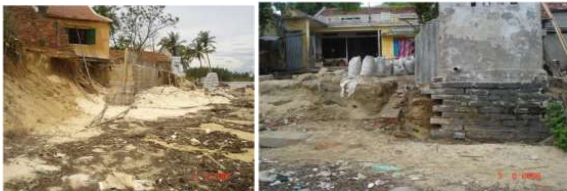
Hình 3: Sạt lở bờ biển Núi thành (trái) và Mộ Đức (phải), tỉnh Quảng Nam
