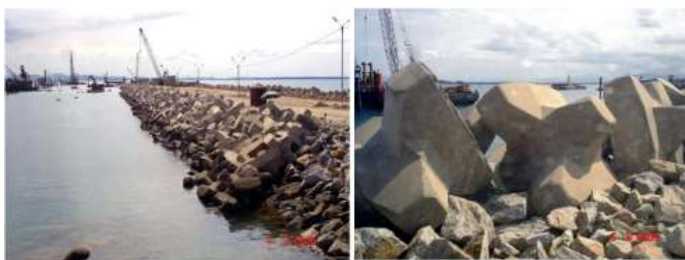
Hình 16: Hình thức kè mỏ hàn chắn cát và phá sóng tại các cửa sông miền trung
