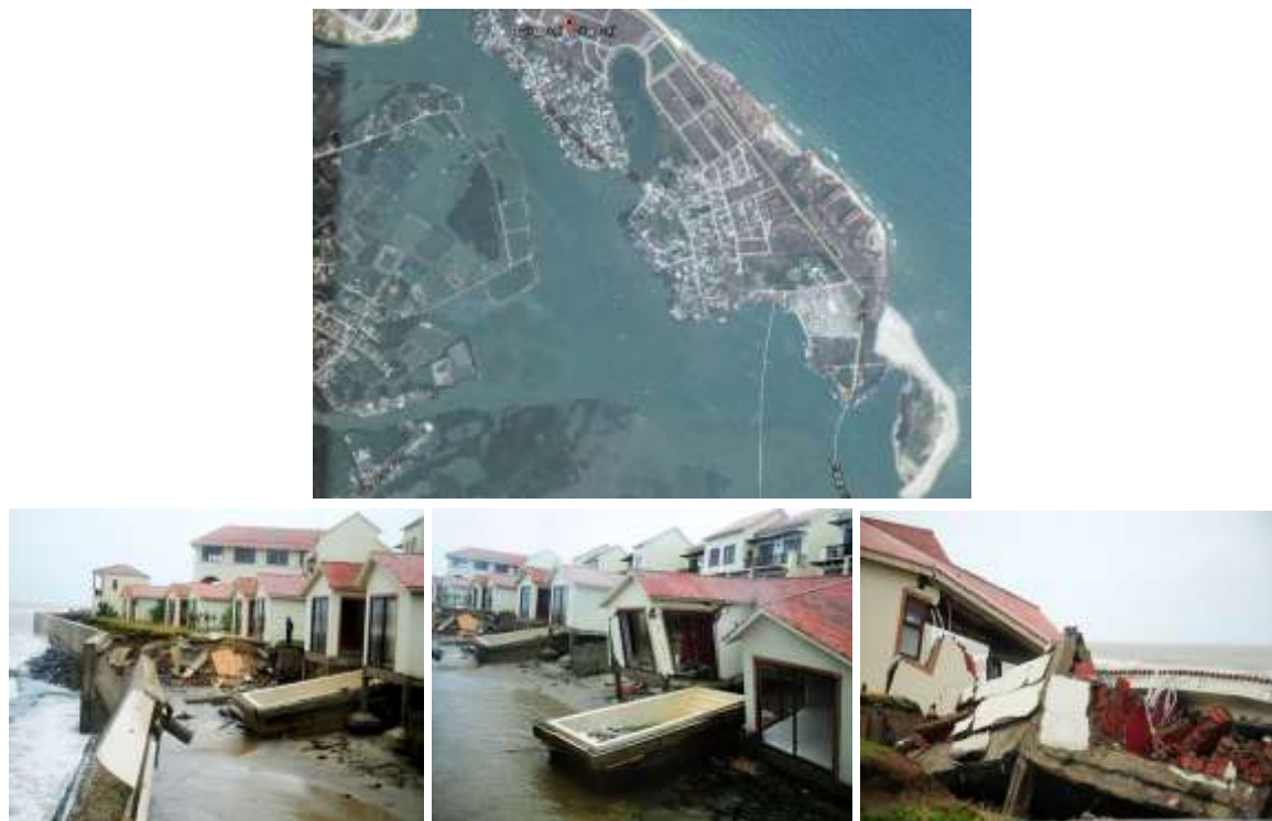
Hình 11: Các resort được xây dựng trên khu vực biến động trở thành đối tượng dễ bị tổn thương lại dẫn tới tình trạng lúng túng tìm giải pháp bảo vệ.
