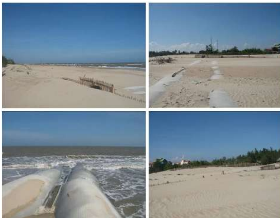
Hình 9: Áp dụng thành công Stabiplate tại bãi biển Lộc an Vũng tàu.
