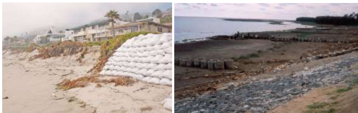
Hình 6: Gia cố bảo vệ mái bằng bao tải cát (trái) và Đá hộc lát mái kết hợp các mô hàn (phải)
