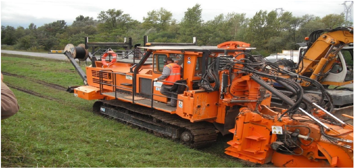
Hình 6. Máy đào hào được chủ yếu sử dụng trong lắp đặt
