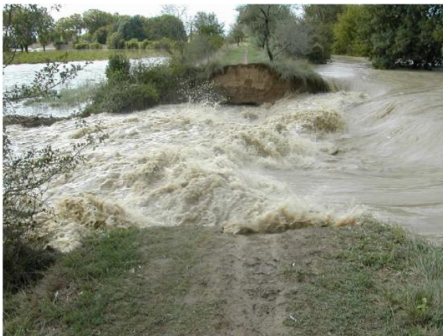
Hình 3: Vỡ một đoạn đê ở Petit Rhône, 2003, Pháp
