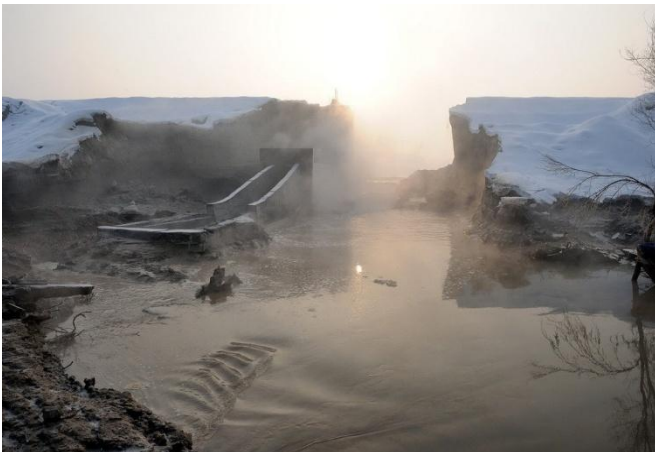
Hình 8: Vỡ ở đập Lianfeng, Trung Quốc
