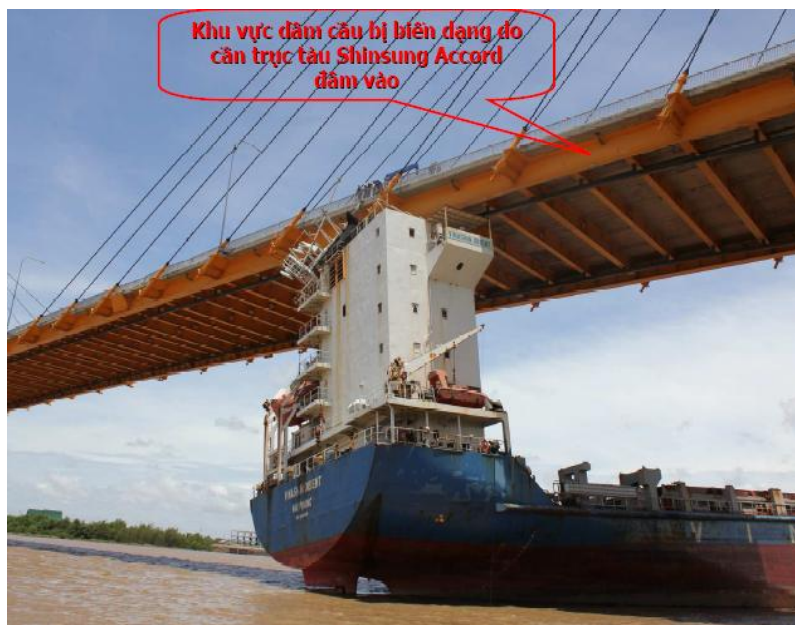
Hình 4. Hư hỏng khi va chạm
