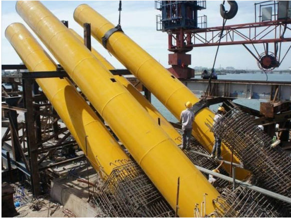
Hình 14 : Long môn lắp đốt chân
