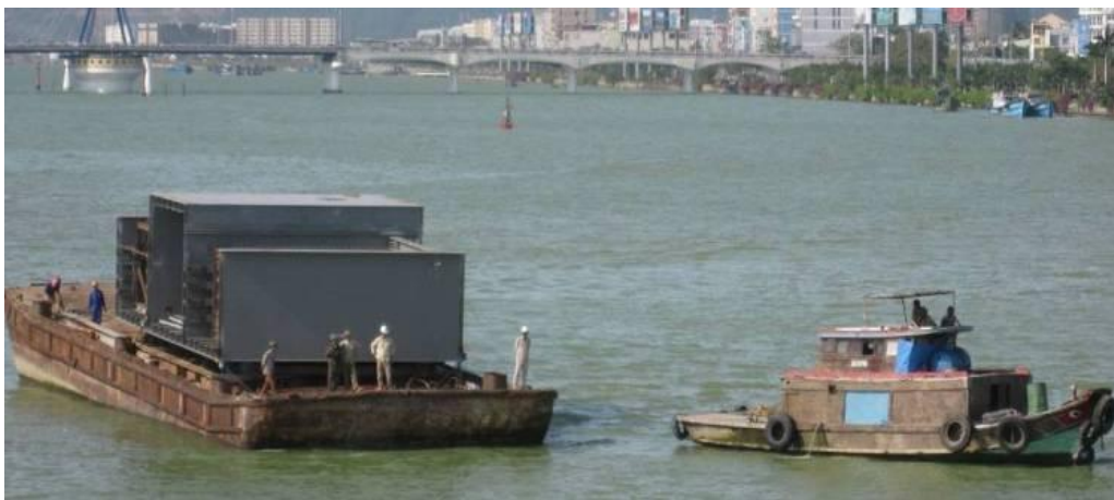
Hình 9: Dùng Xà lan đưa dầm vào vị trí thi công.
