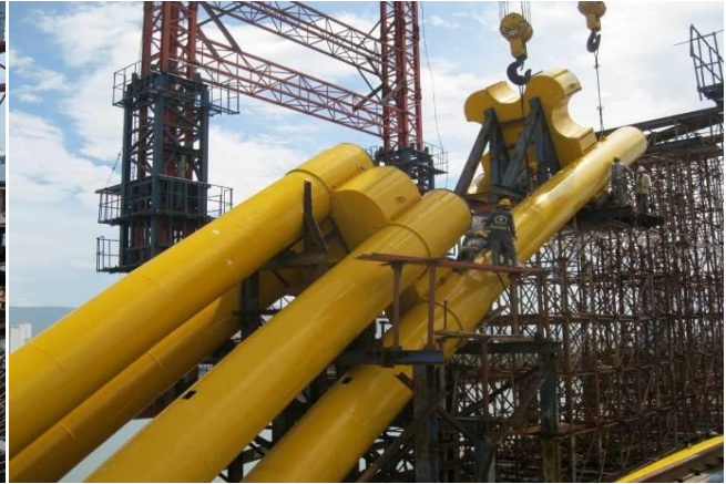
Hình 15 : Lắp mâm kẹp
