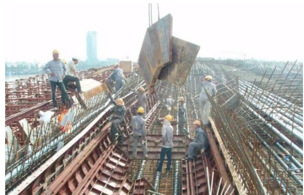
Hình 4: Lắp dựng ván khuôn lõi.
