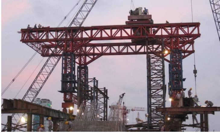
Hình 6: Phương án dùng long môn cầu lắp long môn cầu lắp
