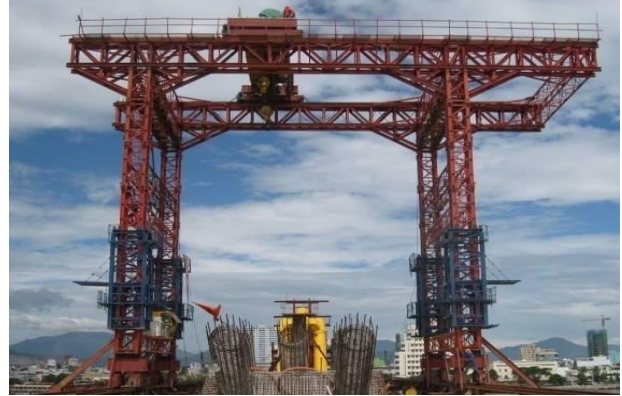
Hình 8: Long môn thi công vòm
