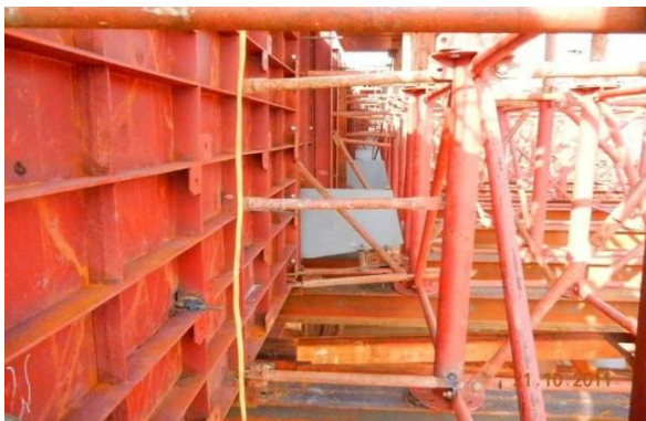
Hình 3: Lắp dựng ván khuôn thành
