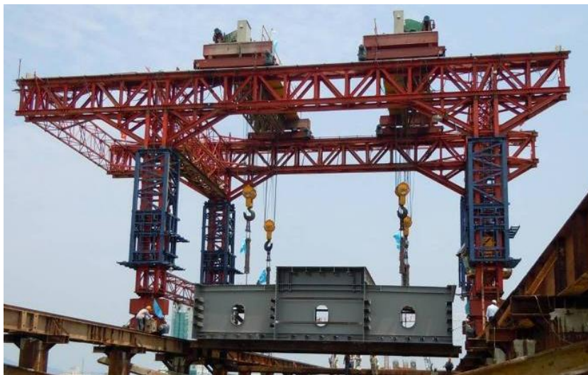
Hình 10: Long môn chuyển dầm vào vị trí thiết kế.
