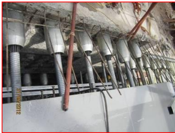
Cáp DUL đang được lắp đặt
