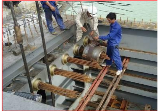
Cáp DUL mỗi nối đang được căng kéo
