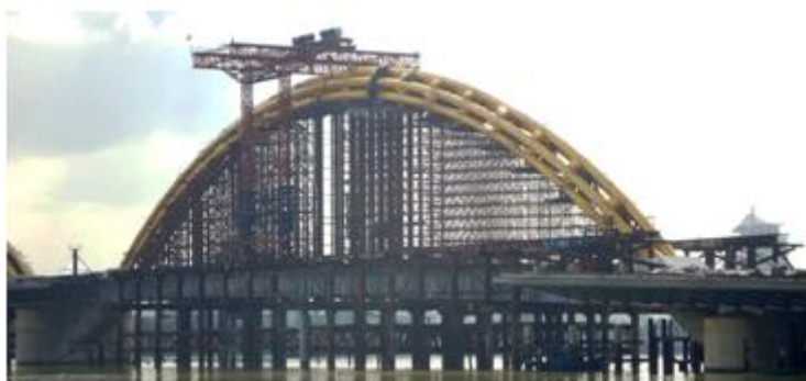
Vòm thép đang thi công
