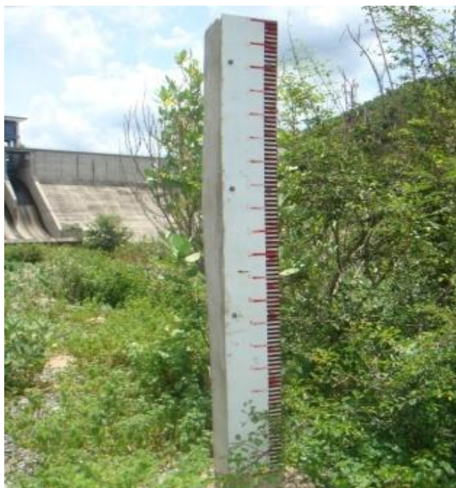
Hình 2. Cột thủy chí ở hạ lưu đập Lòng Sông
