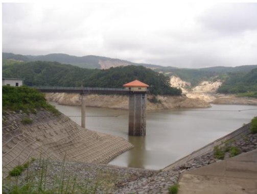
Hình 2. Sạt trượt tại lòng hồ, đứng trên đập nhìn về phía thượng lưu
