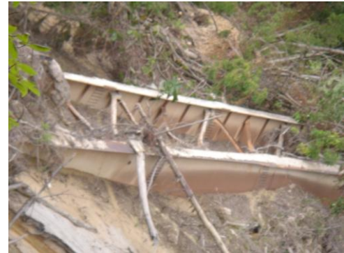
Hình 6. Dầm cầu thép bị ném về thượng lưu vị trí này cách vị trí cũ khoảng 100m
