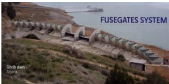
Hình 1. Đập tràn Ghib (Algeria)
