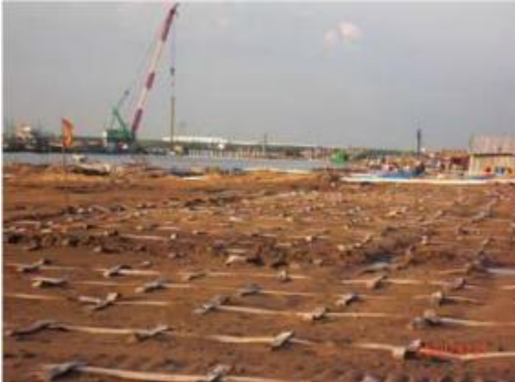
Hình 4.1b. Hiện trường thi công cải tạo đất
