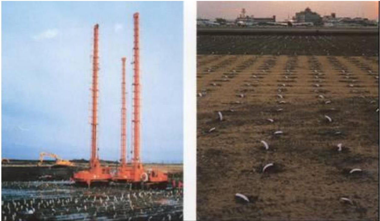
Hình 3.3 Phương pháp thoát nước bằng bắc thấm
