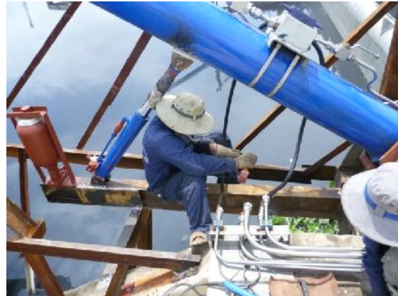
H11. Lắp gong chống trộm và sơn lại
