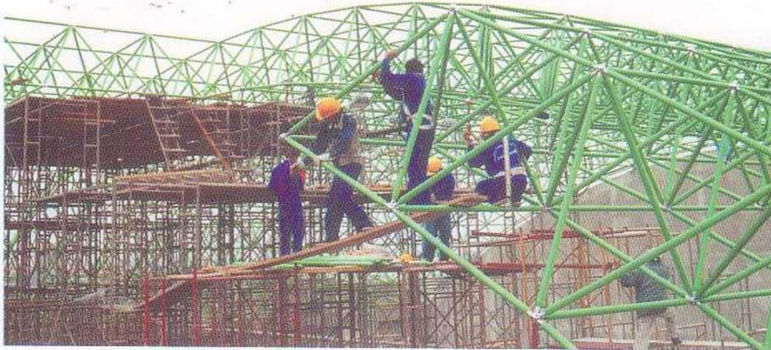
Lắp dựng module 6
