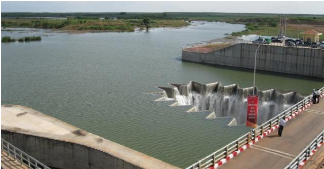
Đập tràn Phước Hòa (Bình Dương – Bình Phước) với ngưỡng tràn răng cưa
