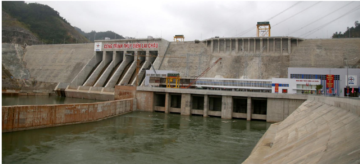
Đập Thủy điện Lai Châu
