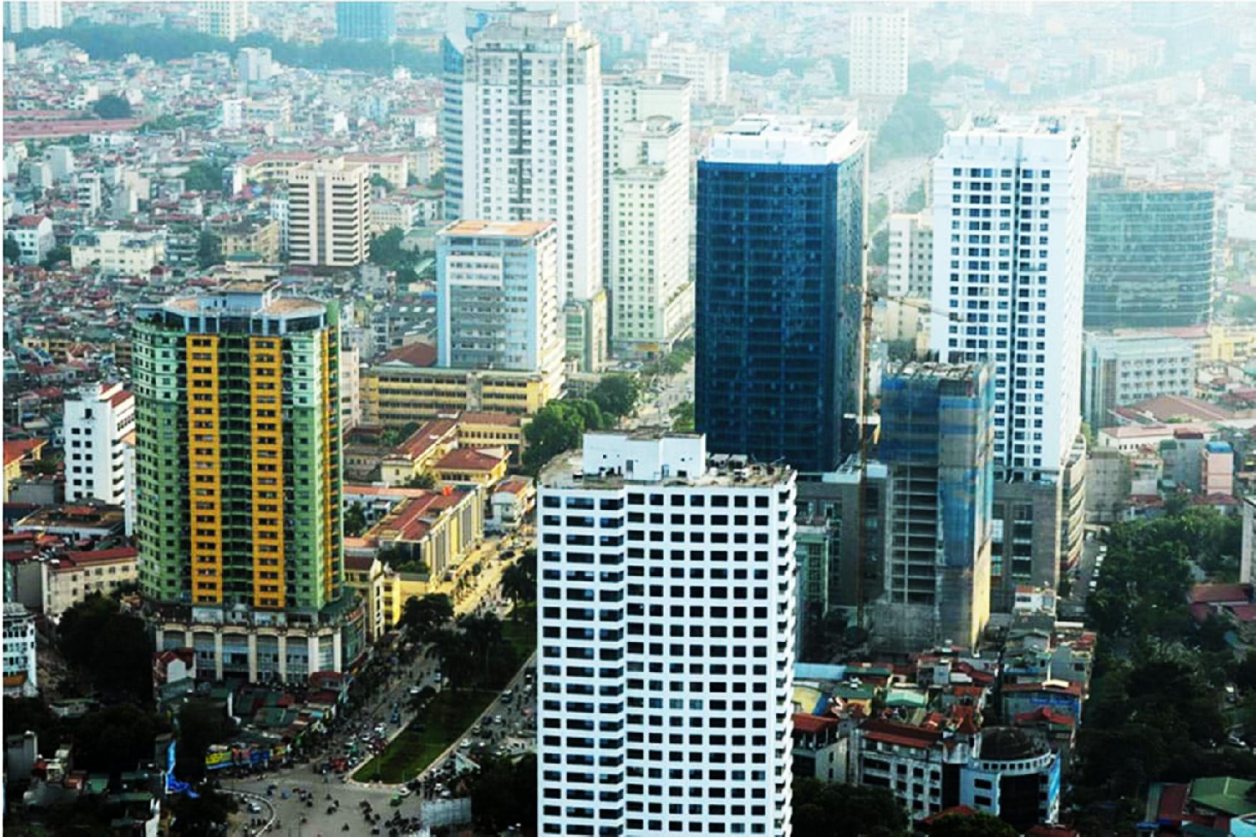
Tuyến đường Nguyễn Chí Thanh (Hà Nội) từng được vinh danh đẹp nhất Việt Nam nay đã “nghẹt thở” bởi hàng chục tòa cao ốc, chung cư san sát. Ảnh: Tiến Tuấn
