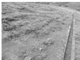
Hình 1. Vết tích do bị thấm ra mái hạ lưu, gây lún và sạt.
