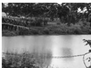
Hình 2. Đập Suối Đĩa, xã TuTra, huyện Đon Dương, Lâm Đồng các cây lớn mọc trên đập
