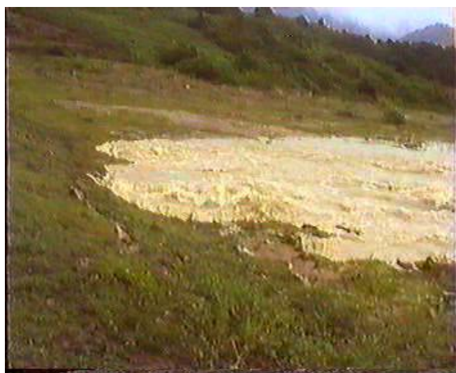
Hình 3: Sự cố đập Am Chúa – Khánh Hòa
