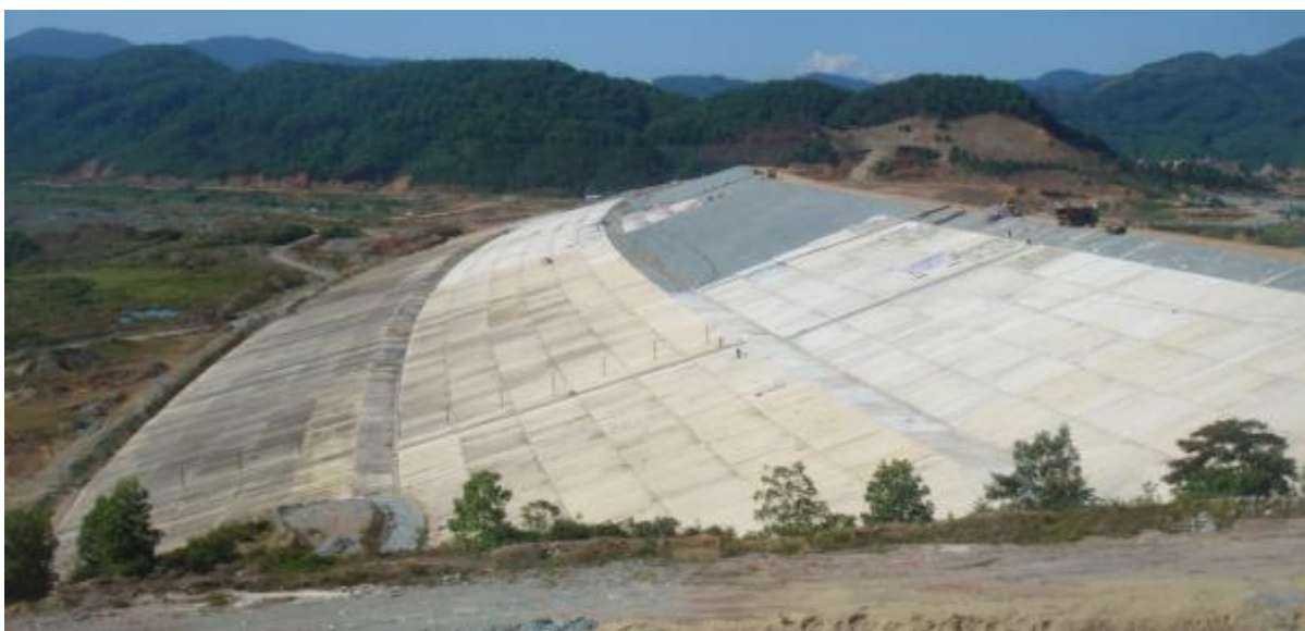
Mái thượng lưu đập chính
