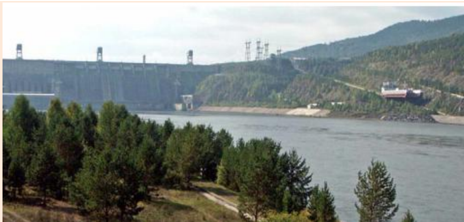
Nhìn từ xa giá đỡ mang xà lan côngtenơ đang leo dốc lên đỉnh đập
