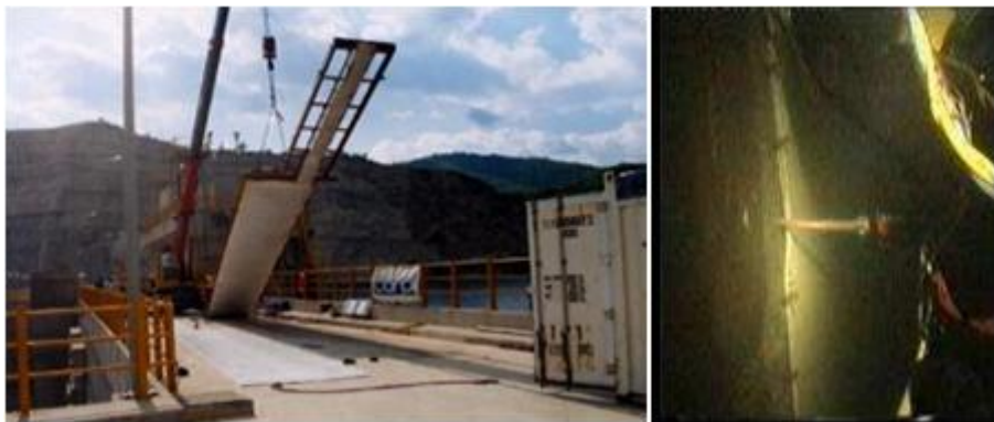
Màng geocomposite trước và sau khi hạ xuống nước, và sự chuẩn bị vòng đệm biên.
