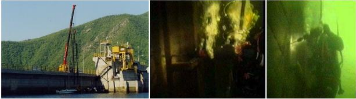
Khoan tạm thời tại đập RCC Platanovryssi (Hy Lạp, 2002).
