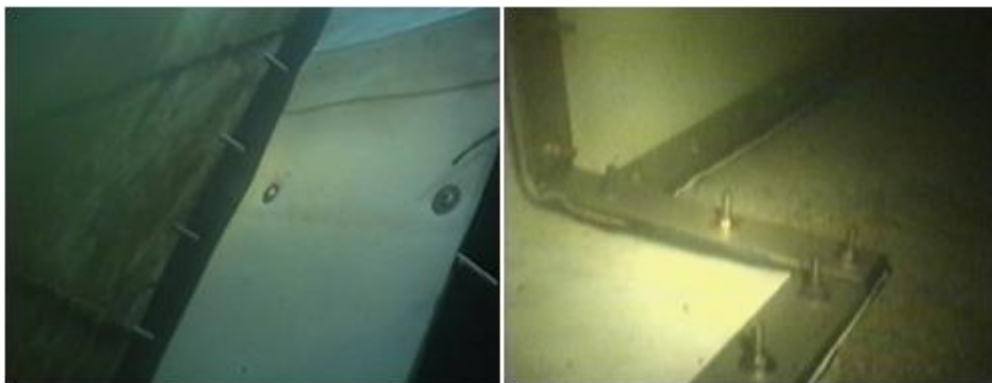
Đệm vòng tại vòng đệm kín và vòng đệm kín được hoàn thành.
