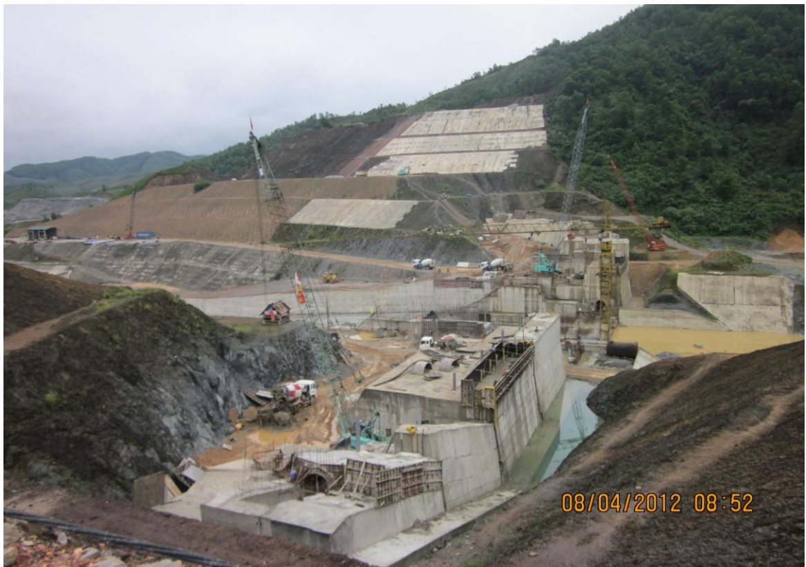
Đập không tràn bờ trái và phải
