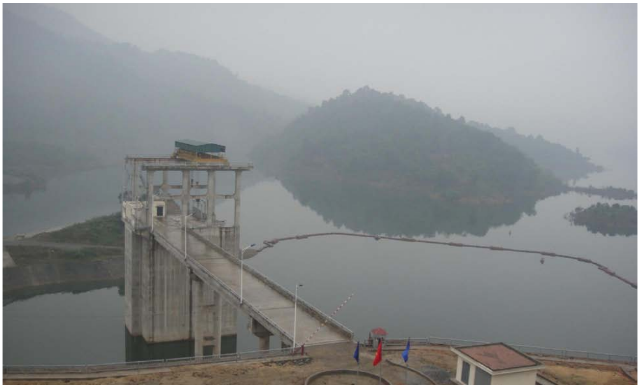
Cửa lấy nước vào tunen của nhà máy thủy điện
