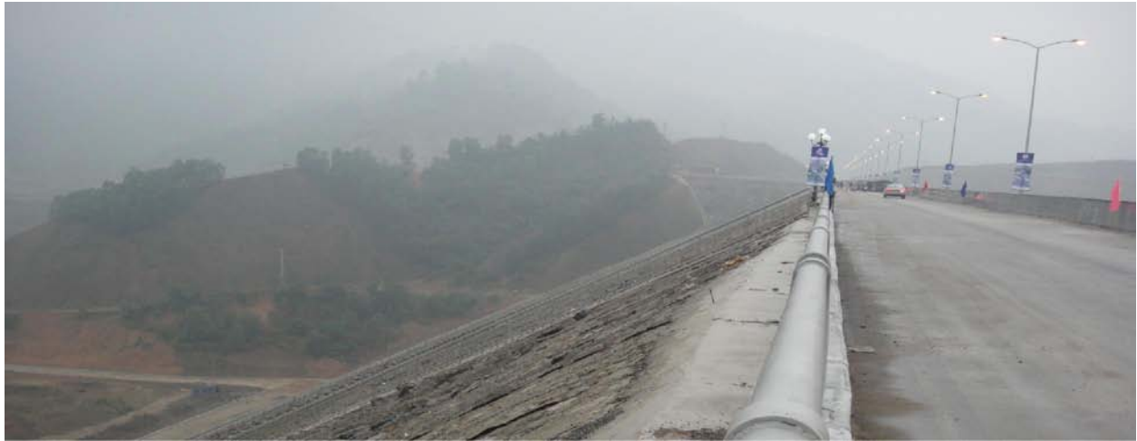
Mái hạ lưu đập
