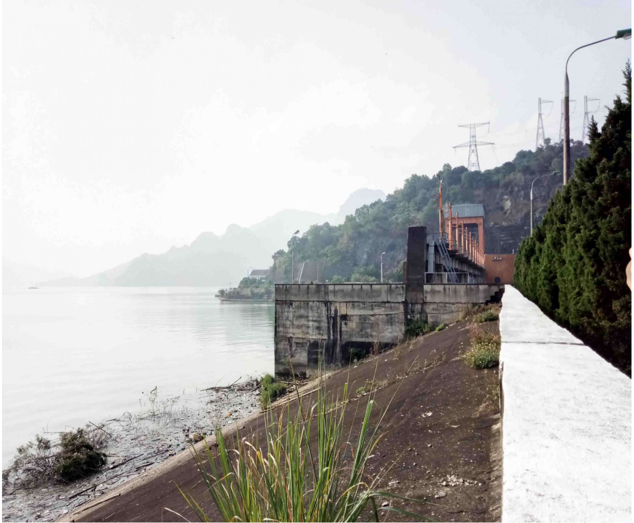
Thân đập thủy điện. Ảnh: Thi Ân
