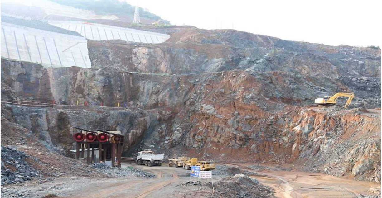
Thi công hố móng nhà máy
