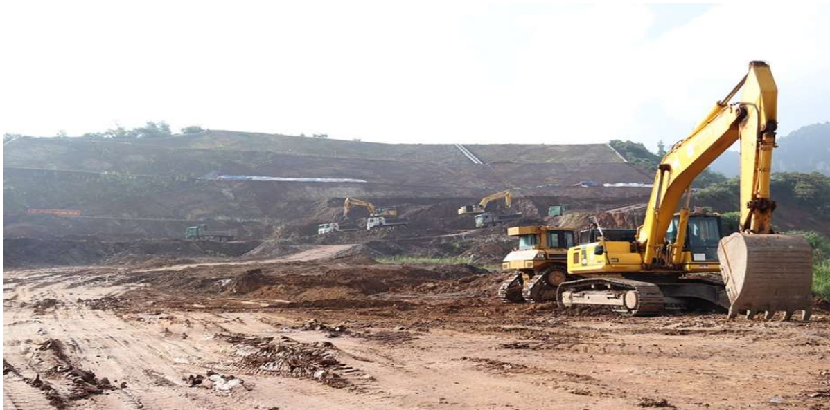
Thi công cửa nhận nước của Nhà máy Thủy điện Hòa Bình mở rộng
