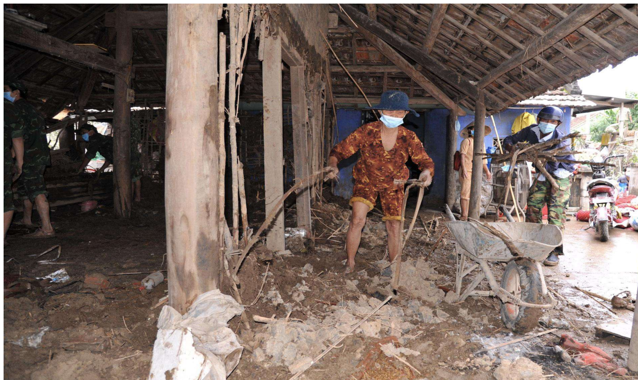
Căn nhà bà Phạm Thị Quờn ở thôn Thạnh Hội, xã Sơn Hà, H.Sơn Hòa (Phú Yên) bị lũ làm hư hỏng nặng
