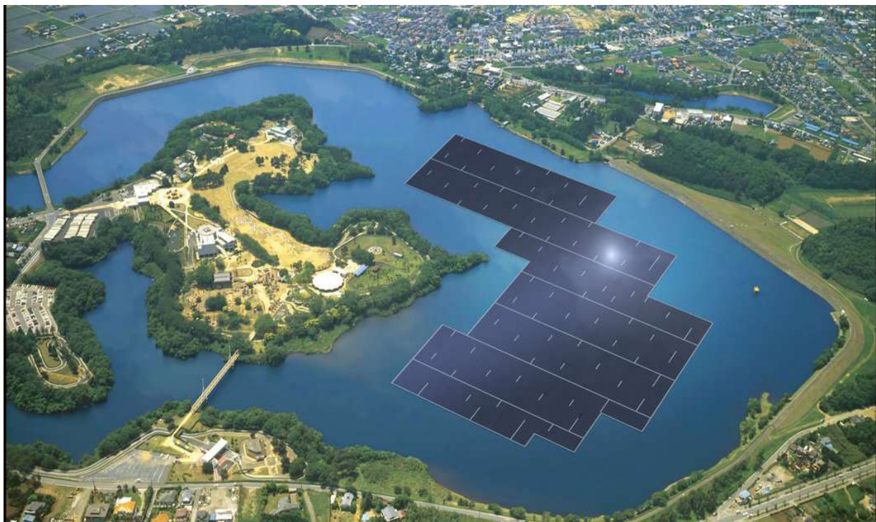
Nhà máy ĐMT nổi công suất 13,7MWp tại hồ Yamakura, Nhật Bản
